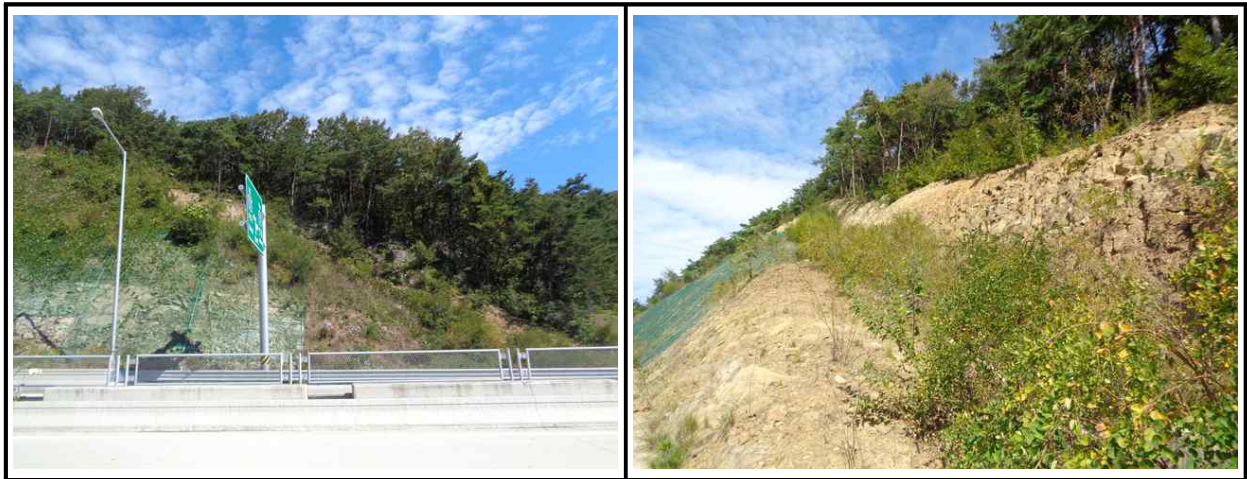
【그림 34.3.1】 상부자연사면 전경
