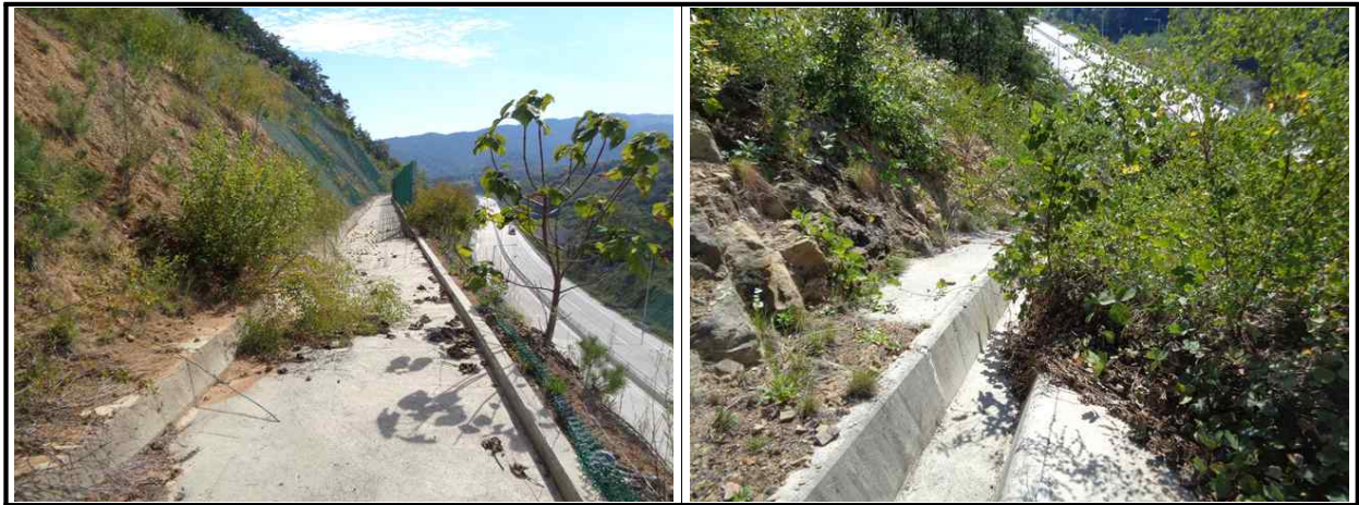
【그림 34.3.3】 배수시설 전경
